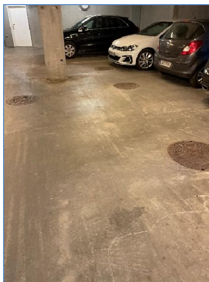
Foto 2: Brønde i kælder
