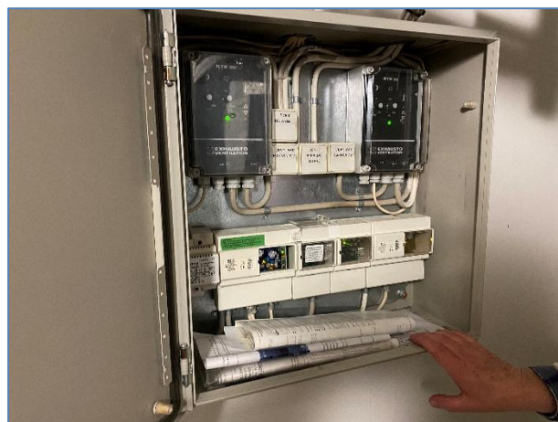
Foto 2: Ventilationsstyring
