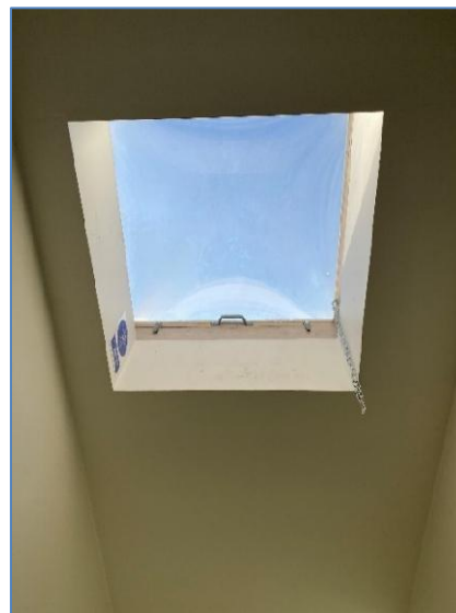
Foto 4: Vindue til opgang
