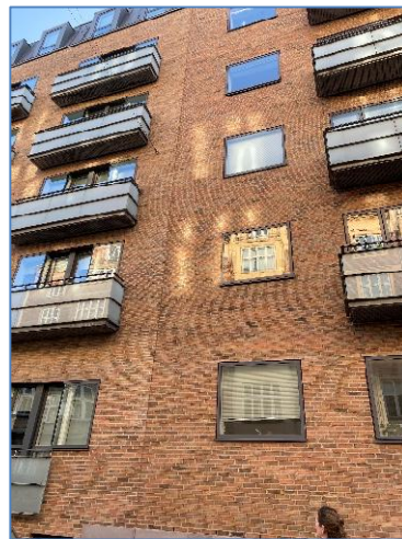
Foto 2: Vindue til bolig
